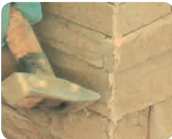
Picchiettare con il martello per ottenere un effetto naturale
