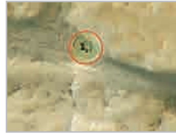
La testa della vite va leggermente sotto il filo del pannello
