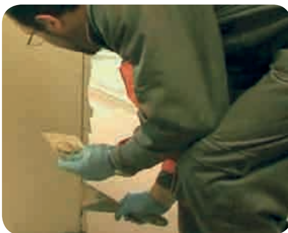
Stendere un abbondante strato di stucco
