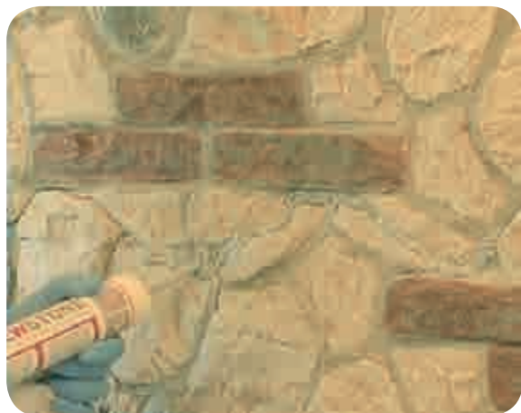
Stendere con cura lo stucco nelle fughe
