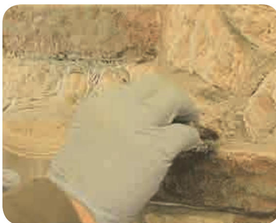
Tamponare lo stucco per dare un effetto granuloso
